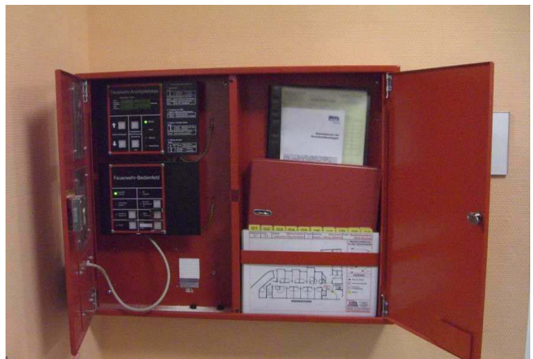
Bild 2: Feuerwehr-Informationszentrale geöffnet
