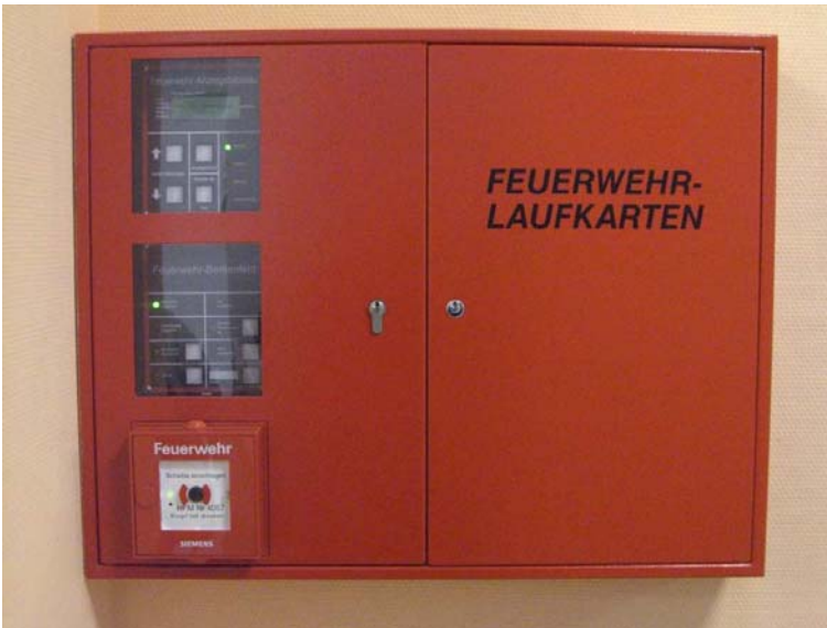
Bild 1: Feuerwehr-Informationszentrale
