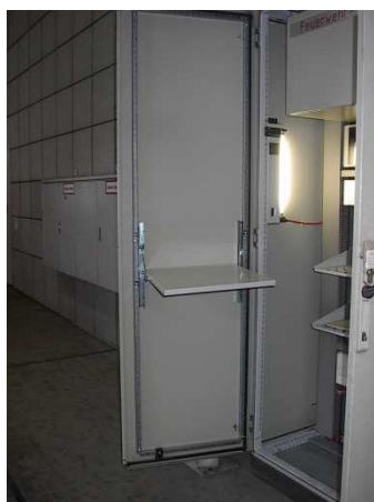
Ausklappbarer Tisch in der Schranktür zur Ablage von Einsatzunterlagen
