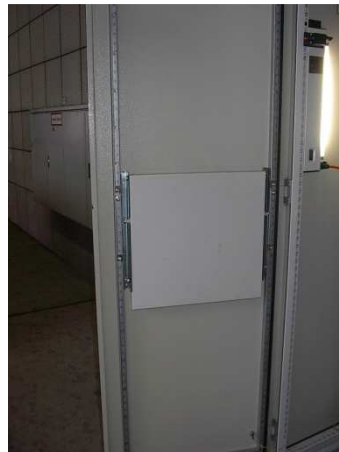
Ausklappbarer Tisch in der Schranktür zur Ablage von Einsatzunterlagen
